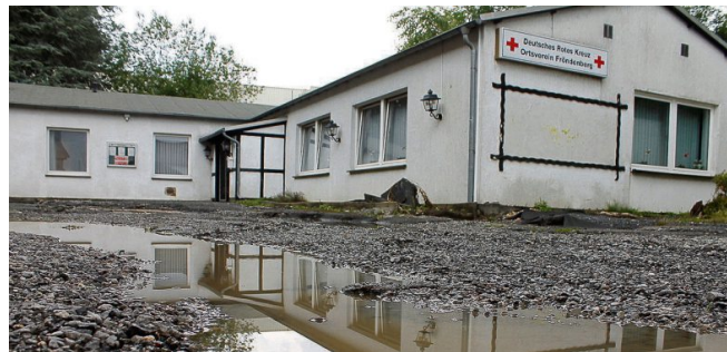
Auch das DRK-Gebäude ist vom Unwetter nicht verschont geblieben. Die Zufahrt ist gesäumt von Pfützen, der Boden aufgeweicht, zum Teil weggespült. FOTO ZANDER
